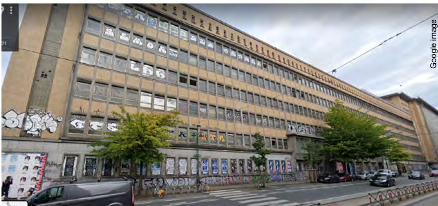
> Het gebouw van het postsorteercentrum, dat toebehoort aan de NMBS
