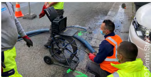
> Inspection des égouts par caméra
