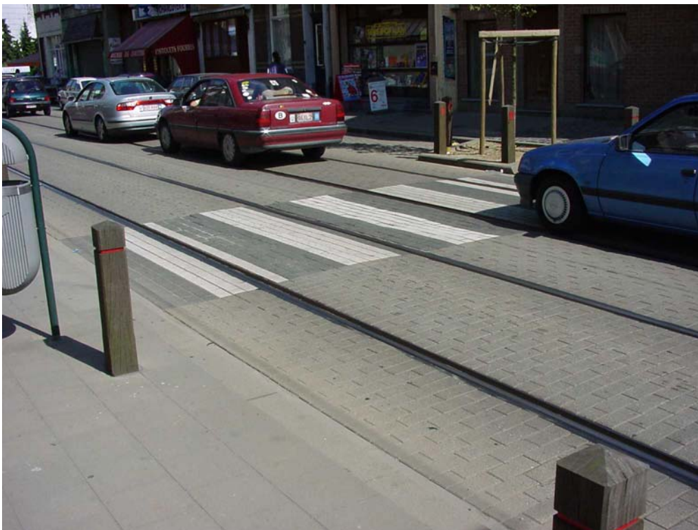
Figure 4 : Chaussée de Neerstalle
