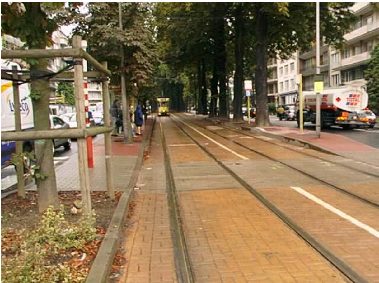
Figure 10 : Avenue Winston Churchill, carrefour avec la Chaussée de Waterloo
